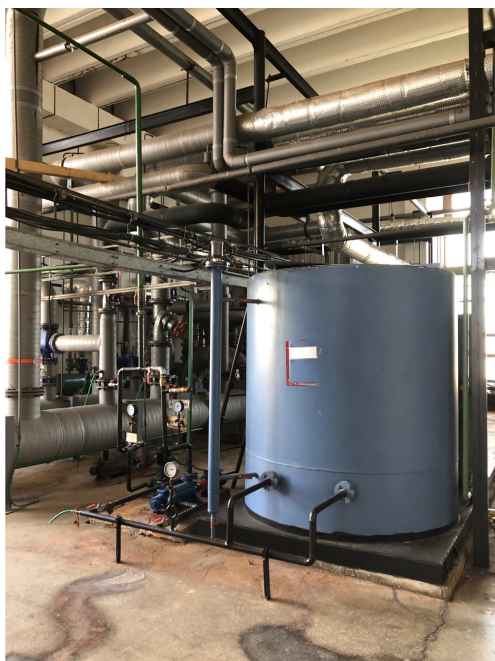
Obrázok č. 18 – Úpravovňa vody pre TÚV
