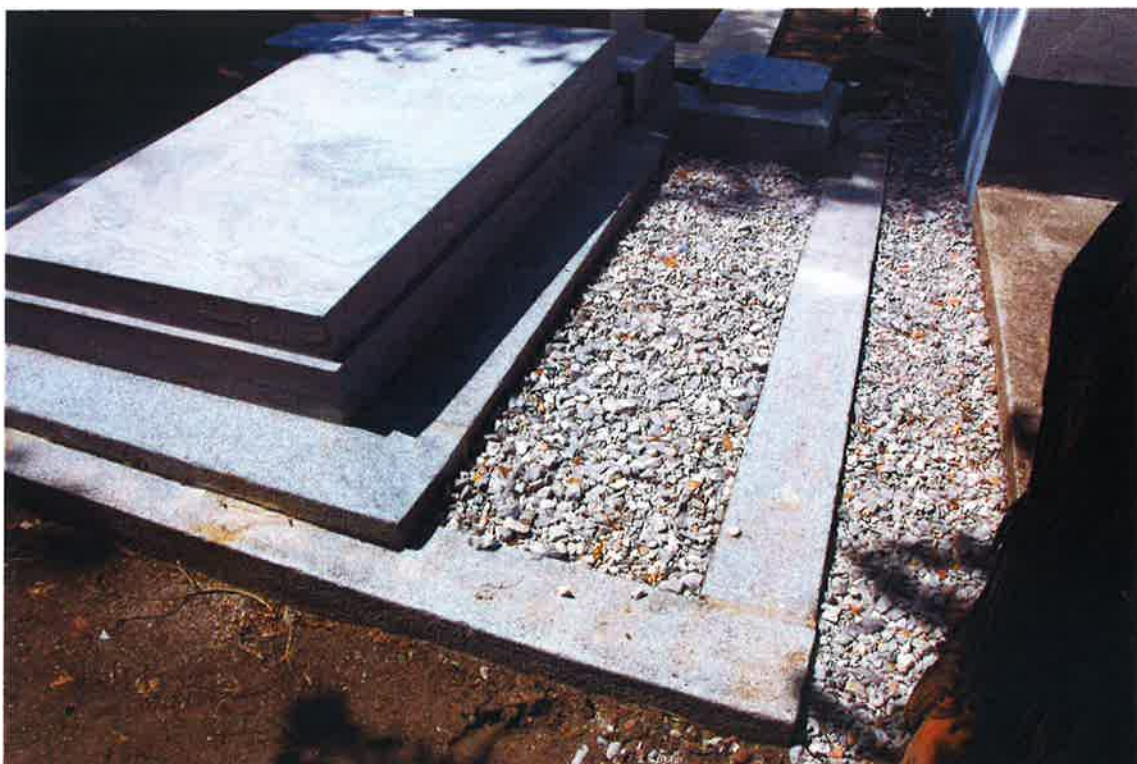
Priestor medzi náhrobkom a domom smútku bol vyplnený rovnako netkanou textíliou a kamennou drťou ako polia pri náhrobku z dôvodu minimalizácie zanášania nečistôt na náhrobok.
