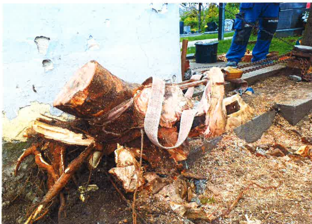
Extrakcia časti koreňového systému použitím kladkostroja.
