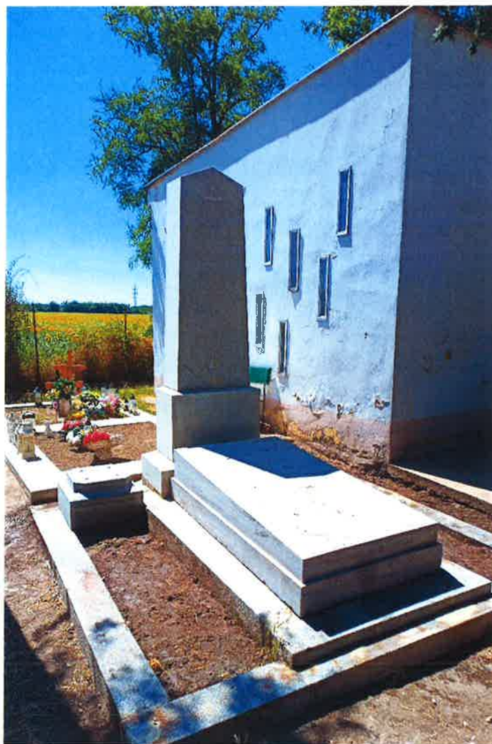
Náhrobok po osadení článkov na pôvodné miesto. Špáry a otvory kotvenia kovovej ohrady boli vyplnené minerálnym kompozitom .
