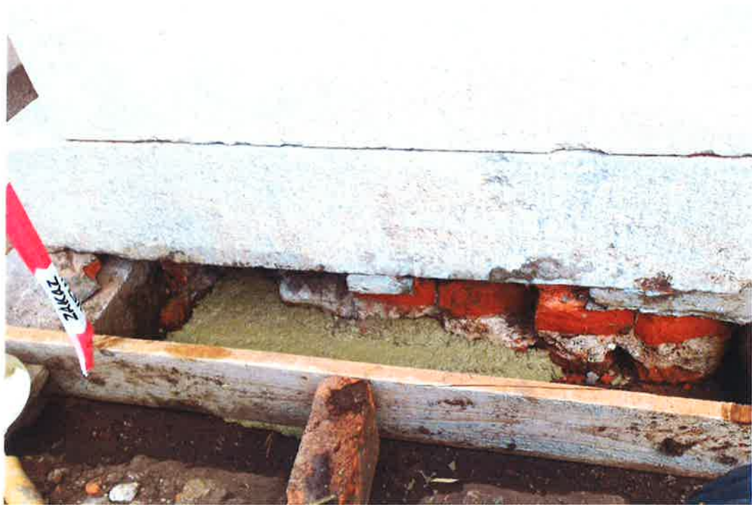
Doplnenie absentujúceho základu minerálnym kompozitom.
