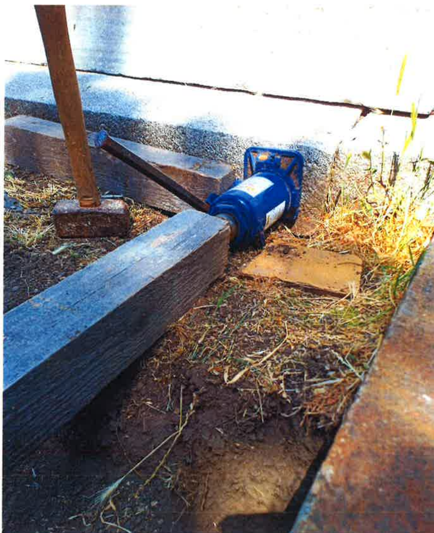
Manipulácia s kamennými blokmi pomocou hydraulického náradia.
