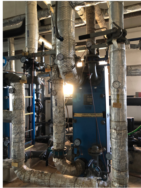
Obrázok č. 17 – Doskové výmenníky tepla na výrobu tepla z geotermálnej vody
