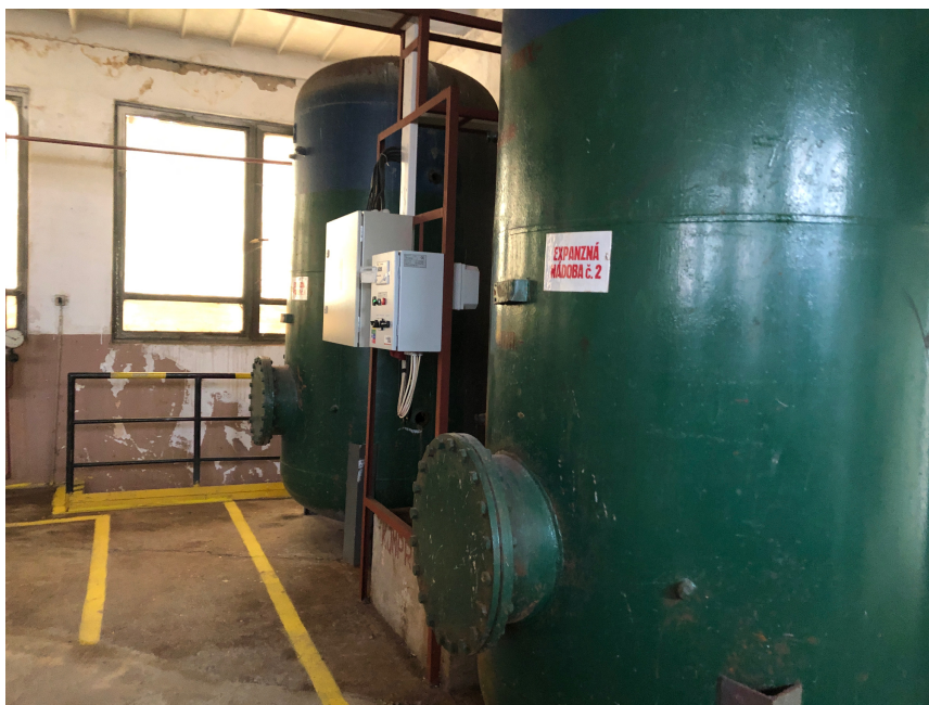
Obrázok č. 8 – Výmenníková stanica tepla VS-3 III – expanzné nádoby
