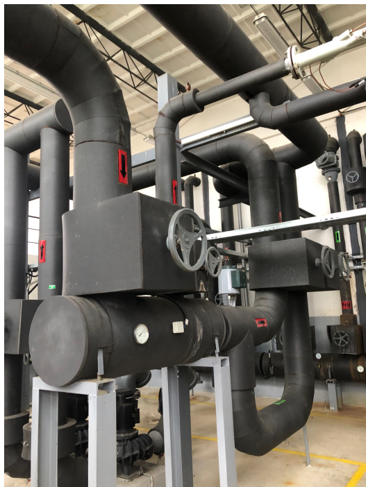
Obrázok č. 11 – Odovzdávacia stanica tepla OST-16 I, II – akumulčná nádrž na TUV
