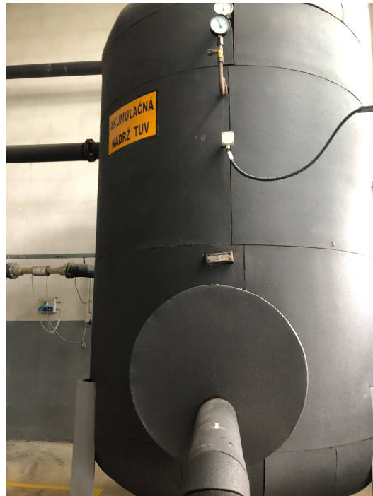
Obrázok č. 11 – Odovzdávacia stanica tepla OST-16 I, II – akumulčná nádrž na TUV
