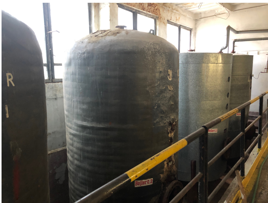
Obrázok č. 7 – Výmenníková stanica tepla VS-3 II - bojler
