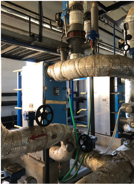
Obrázok č. 17 – Doskové výmenníky tepla na výrobu tepla z geotermálnej vody
