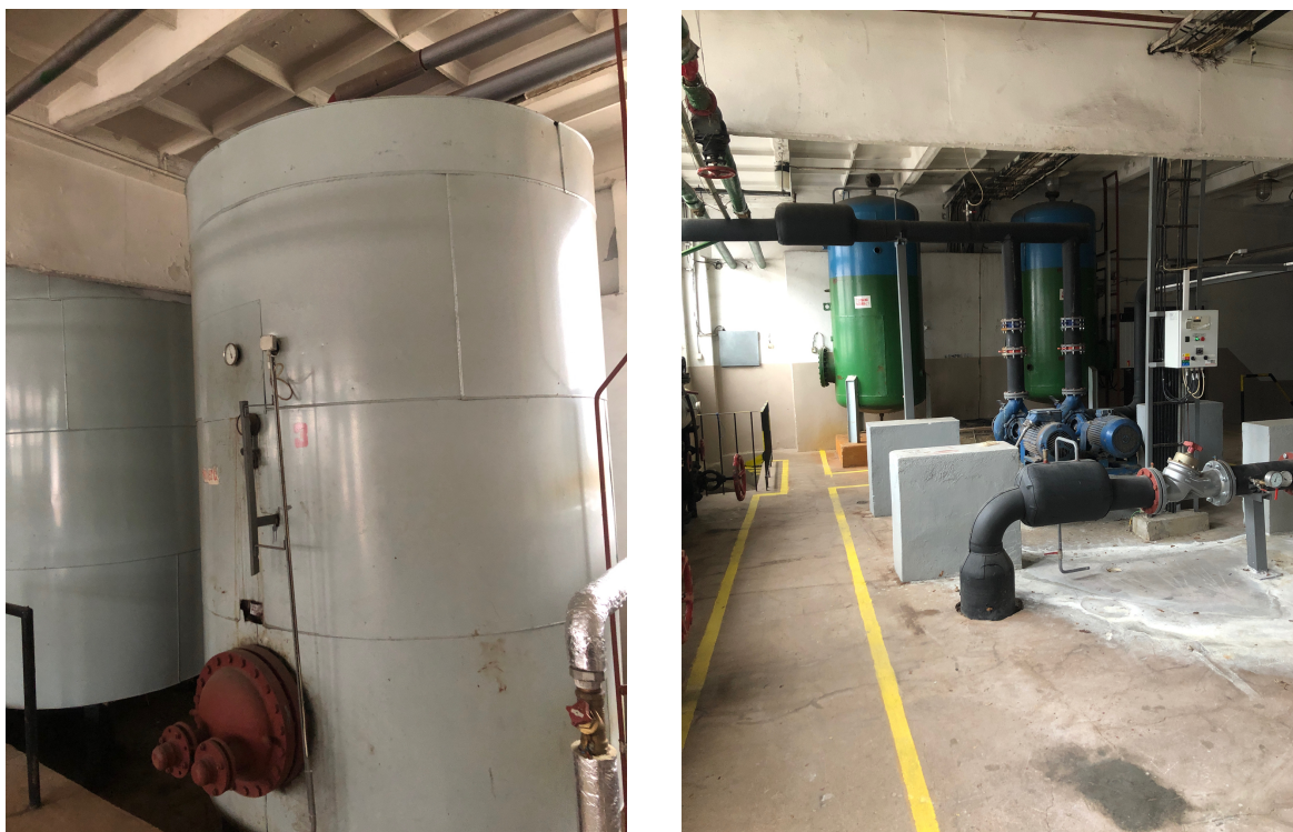
Obrázok č. 3 – Výmenníková stanica tepla VS-1 – bojler a expanzné nádoby
