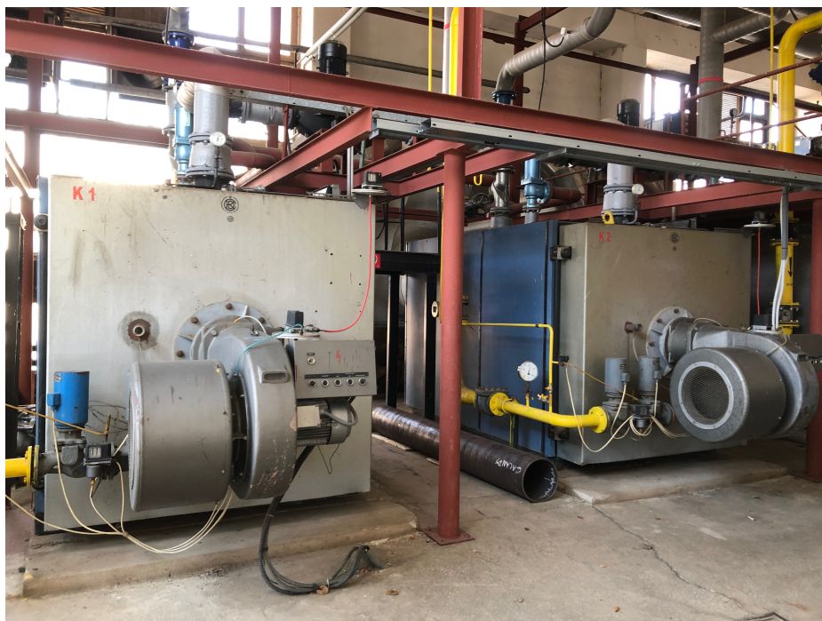
Obrázok č. 14 – Záložná plynová kotolňa – kotle K1 a K2
