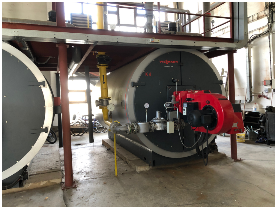
Obrázok č. 15 – Záložná plynová kotolňa – kotle K3 a K4
